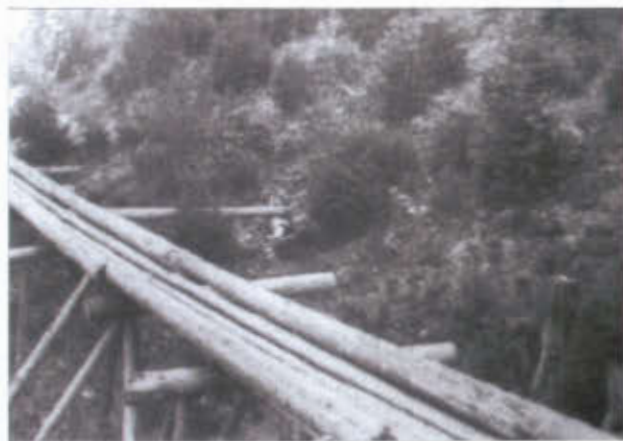
Holzriese im Bereich Kupper
