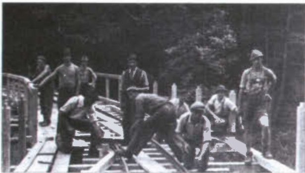
Arbeiter beim Brückenbau
